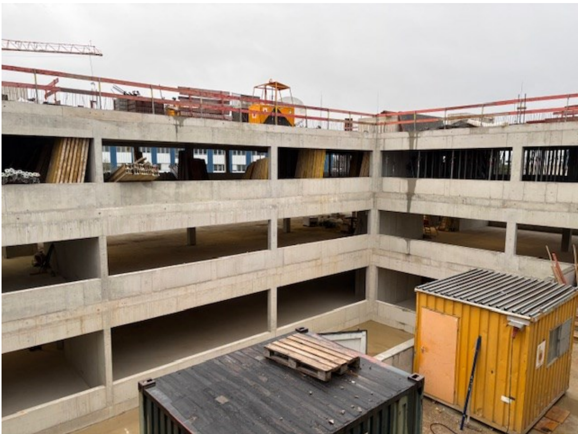
Quelle: DLR (Innenhof Stand Baustelle Mai 2026)
