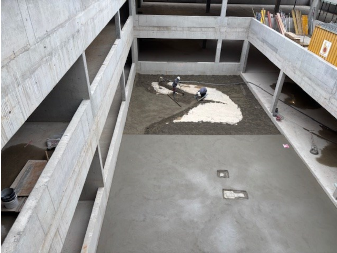
Quelle: DLR (Innenhof Stand Baustelle Mai 2026)
